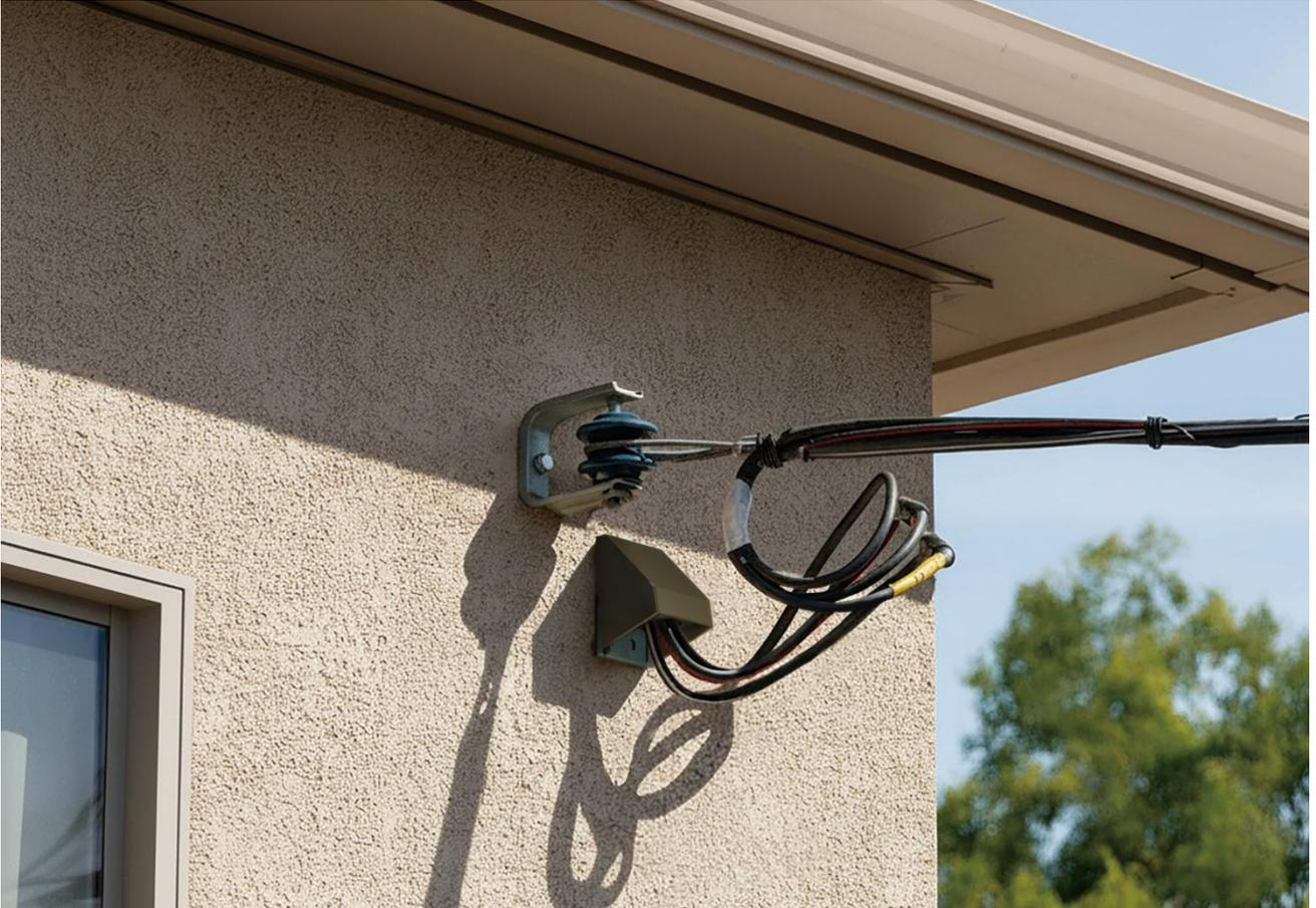
電力線を引き込むためのカバーとしてご使用いただけます。
